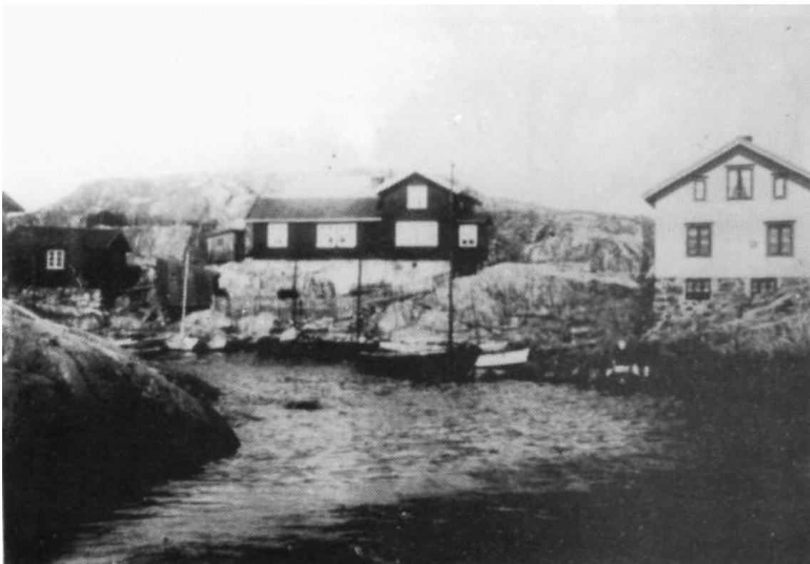
Gamla hamnen, Källö-Knipplas västra sida (1923).
