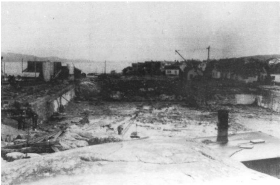
Den nya hamnen under byggnad (1935).
